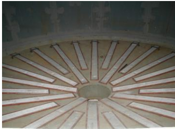
Obr. 5 Provzdušňovací zařízení radiální
