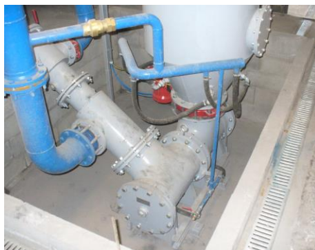
Průtokový podavač se spodkem gravitační komory
