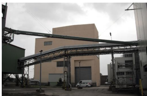
Potrubní most s dopravními potrubími
