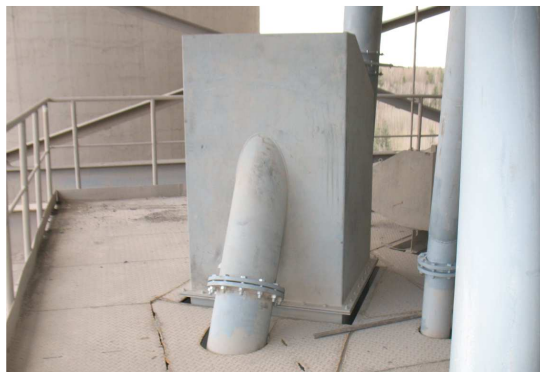
Obr. 4: Expandér na zásobní síle odprašků
