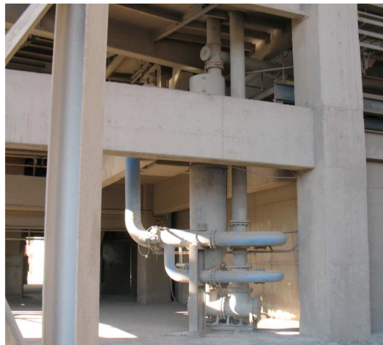
Obr. 2: Průtokový podavač, rozšířená gravitační komora se zužtřením fluidního dopravníku a odprašením
