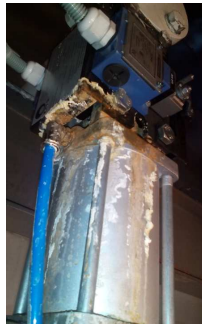
Dopravní potrubí zalepené a zkorodovaný uzávěr – následek zpětného tahu
