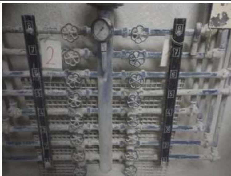
Originální rozdělovač s ručně ovládanými cyklovacími ventily
