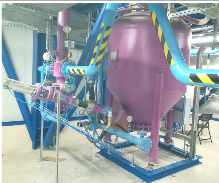
Uvolnění dopravního potrubí a přívodu vzduchu do směšovače
