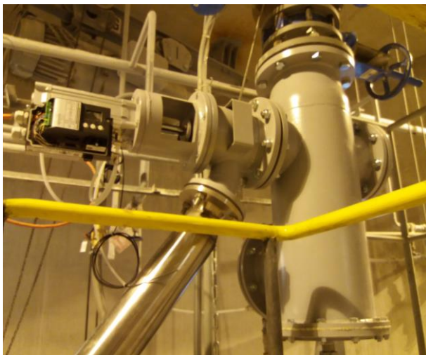
Sestava regulačního vykladače a segregáční komory
