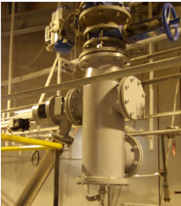
Segregační komora s kontrolním a čistícím hrdlem
