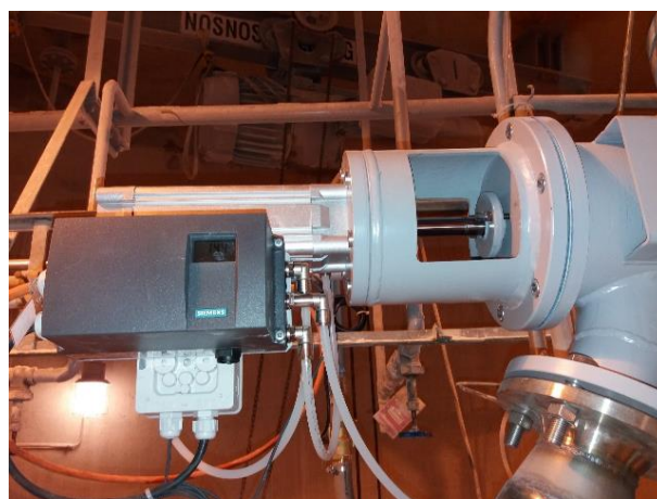
Detail elektropneumatického ovládání regulačního vykladače
