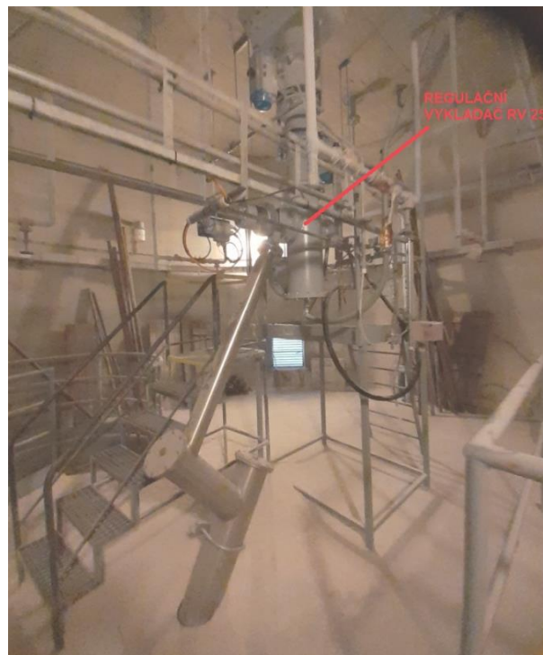
Instalace RV25 s napojením na původní skluz
