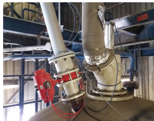
Uzávěr odtlakování komorového podavače
