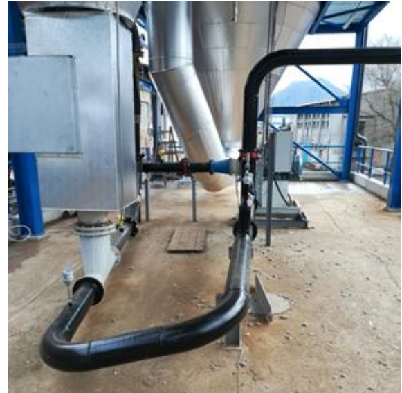
Směšovač pseudopravy s vratným potrubím
