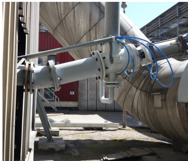
Přifukovací materiálový uzávěr PMU
