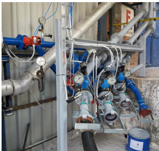
Počátek tří rekonstruovaných dopravních potrubí
