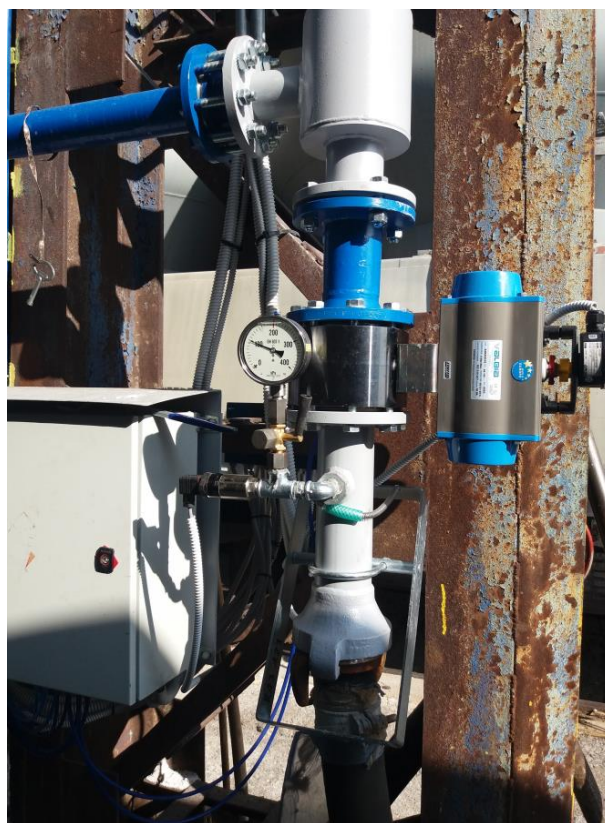
Nové řešení napojovacího místa s přífukem
