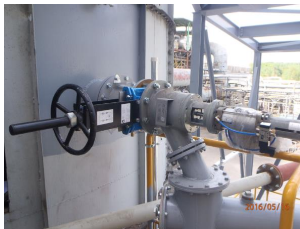
Boční odběr sila s pneumatickým vykladačem PV
