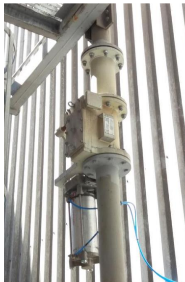
Instalace uzávěru KMU 100 ve svislé větvi dopravního potrubí
