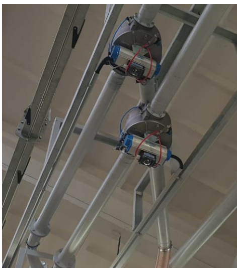
Rozbočky dopravního potrubí s nadouvacím těsněním
