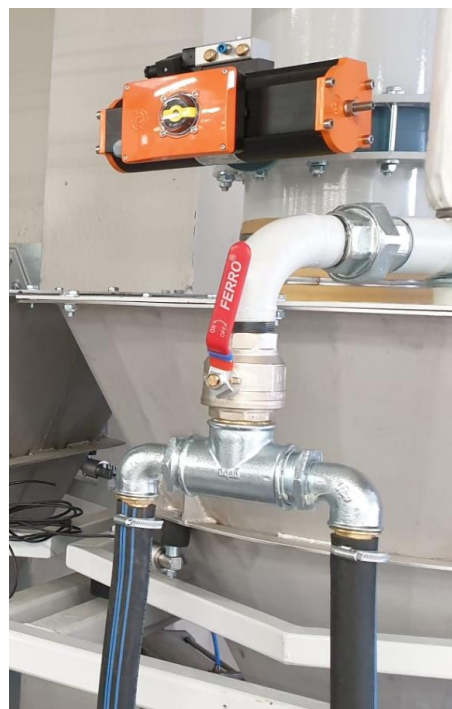
Zaústění odvodu vzduchu kapes dopravního rotačního podavače
