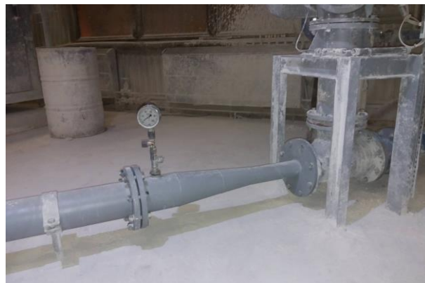
Difuzor ejektoru
