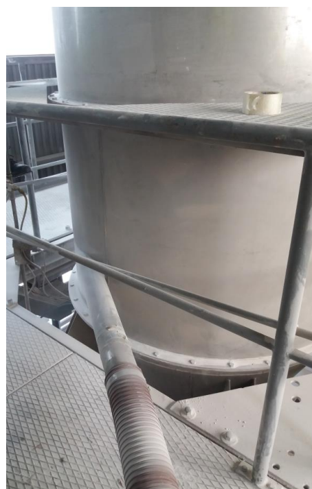
Zaústění dopravního potrubí do zásobníku
