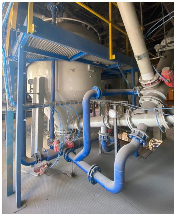
Výstupní potrubí podavače s přífukovacím uzávěrem PMU a uvolňovacím potrubím
